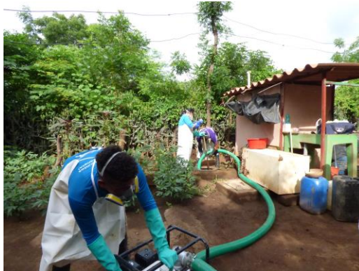
Limpieza del tanque o Pilas
